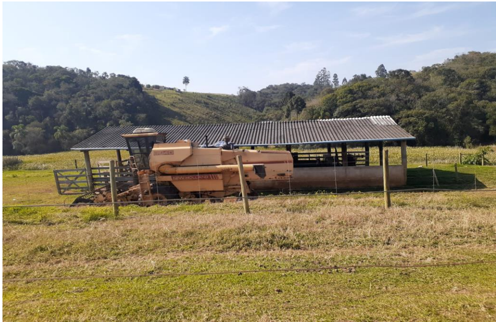
Vista de curral do imóvel avaliado
